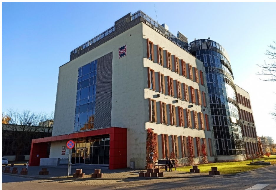
Fot. 1. Budynek dydaktyczny Energis, Wydział Inżynierii Środowiska, Geomatyki i Energetyki na Politechnice Świętokrzyskiej w Kielcach.
