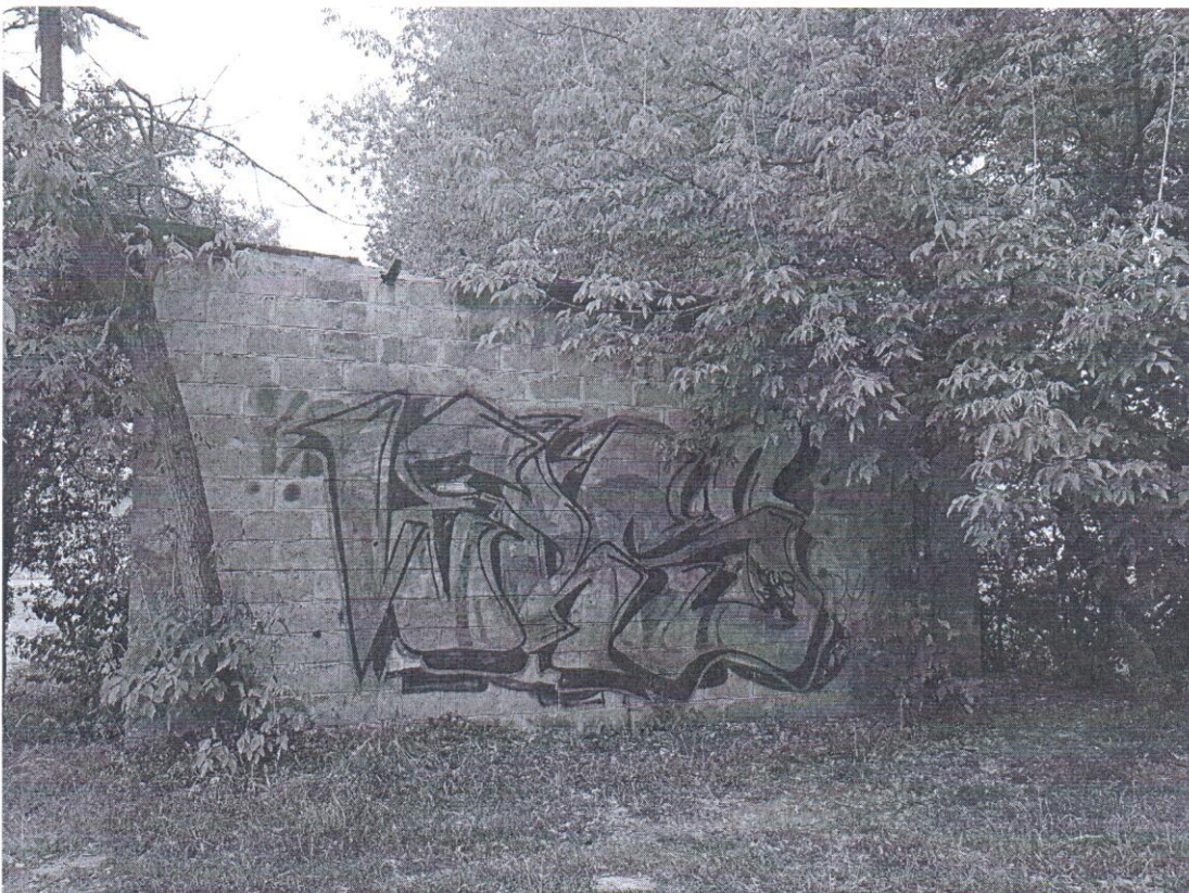
Zdjęcie 6. Wiata przyległa do budynku magazynowego – elewacja północna
