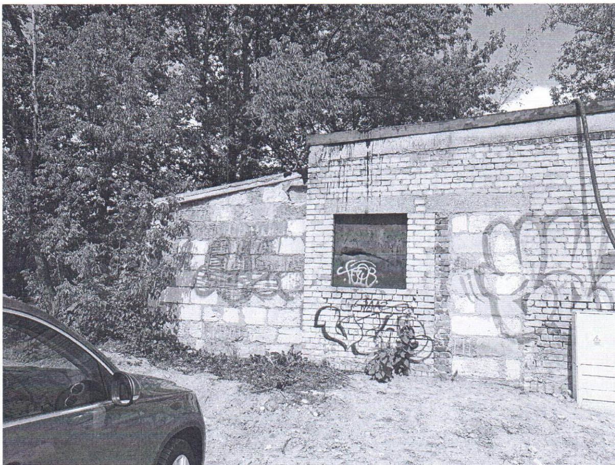
Zdjęcie 4. Przybudówka do budynku magazynowego – elewacja południowa
