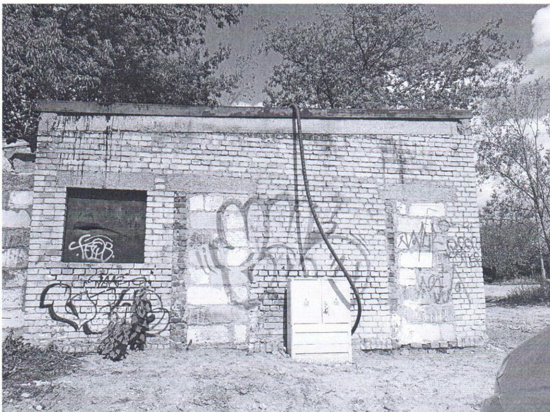
Zdjęcie 3. Budynek magazynowy – elewacja południowa
