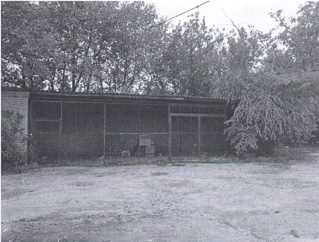
Zdjęcie 5. Wiata przyległa do budynku magazynowego – elewacja wschodnia
