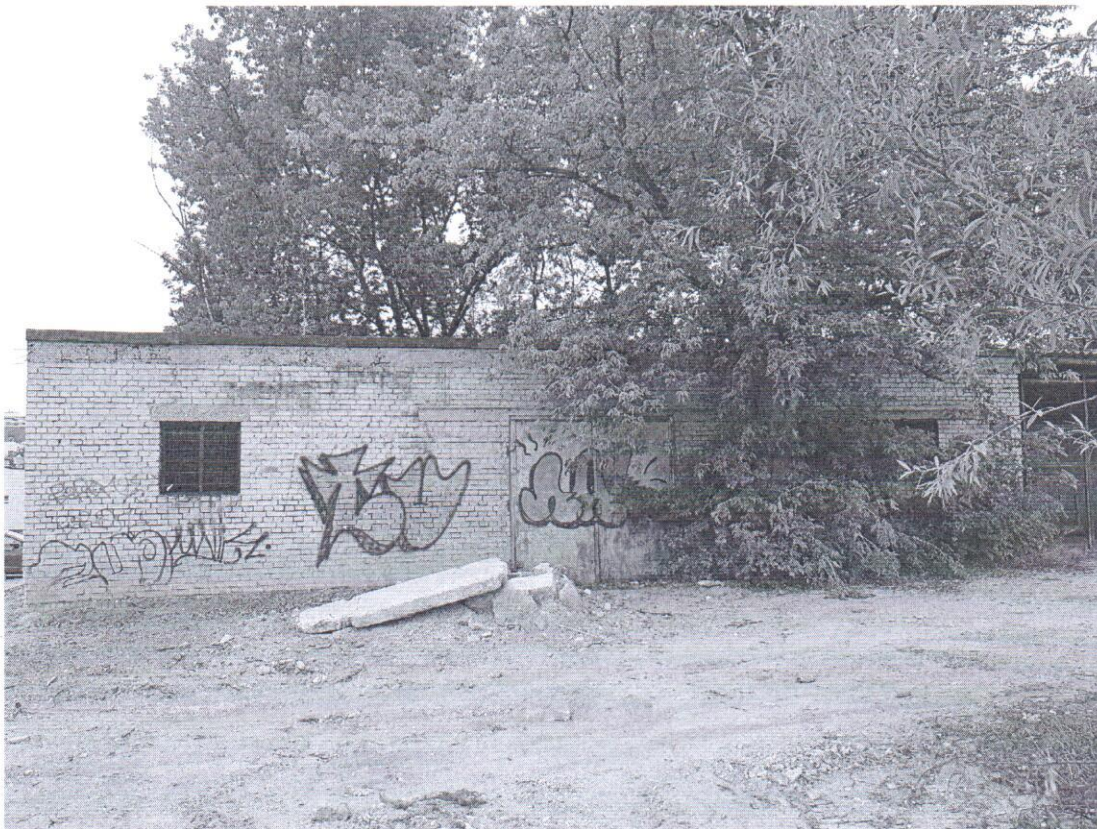
Zdjęcie 2. Budynek magazynowy – elewacja wschodnia
