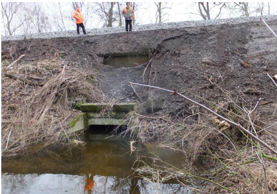
Fot. 12. Przepust ramowy żelbetowy prefabrykowany zainstalowany w przepuscie sklepionym –cegłany z 1876r. Widok od strony toru nr 2
