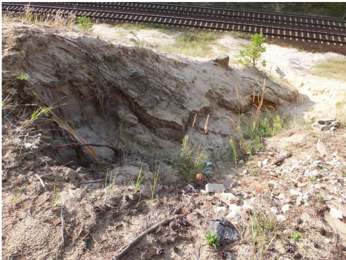
Fot. 4. Leje erozyjne wraz z wypłukanym materiałem drobno-piaszczystym
