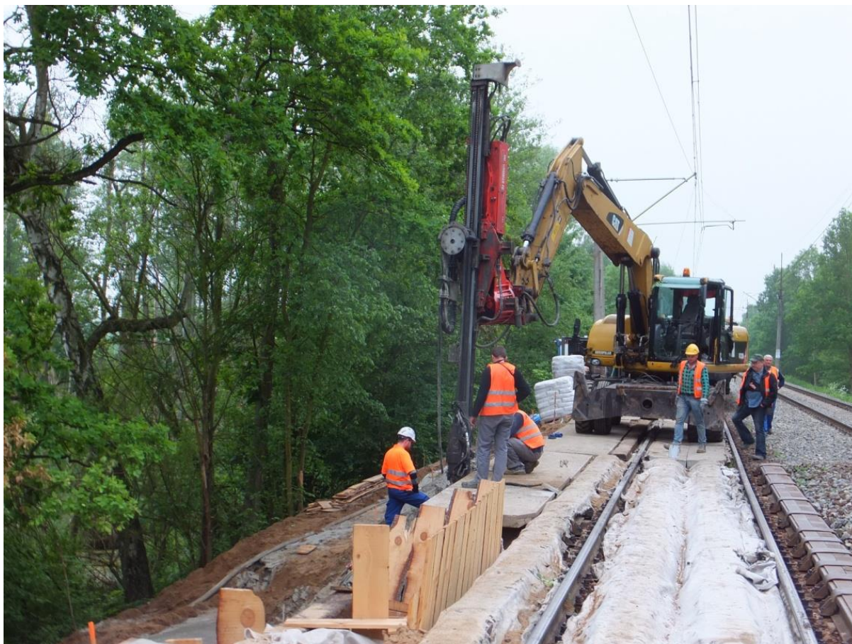
Fot. 14. Naprawcze roboty budowlane – wykonywanie iniekcji niskociśnieniowej
