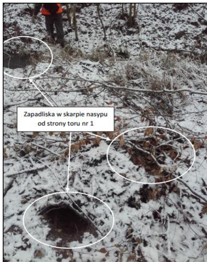
Fot. 24. Zapadliska w skarpie nasypu toru nr 1
