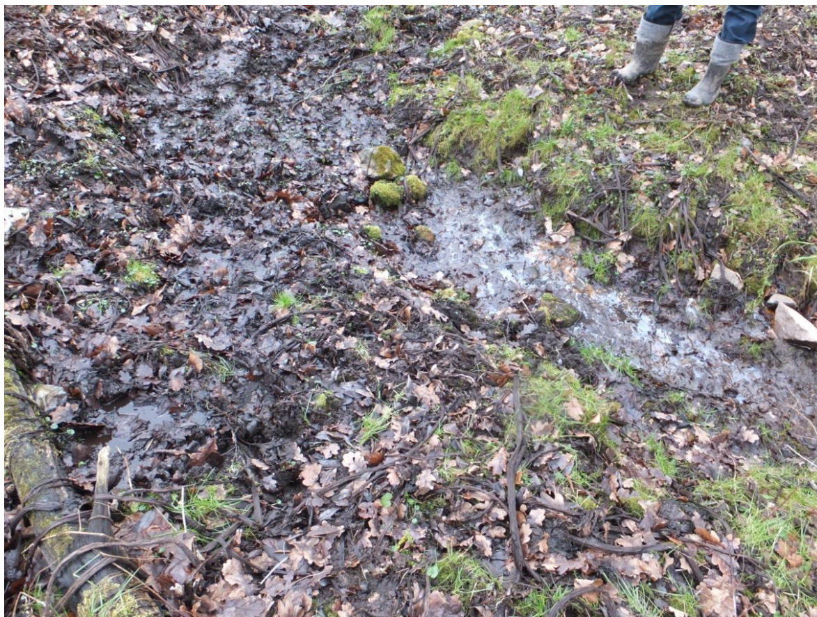
Fot. 7. Wyciek wody powierzchniowej z nasypu u podstawy nasypu
