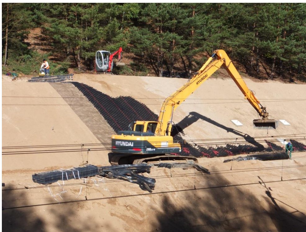
Fot. 5. Naprawa skarpy przekopu – układanie i zasypywanie geosiatki komórkowej
