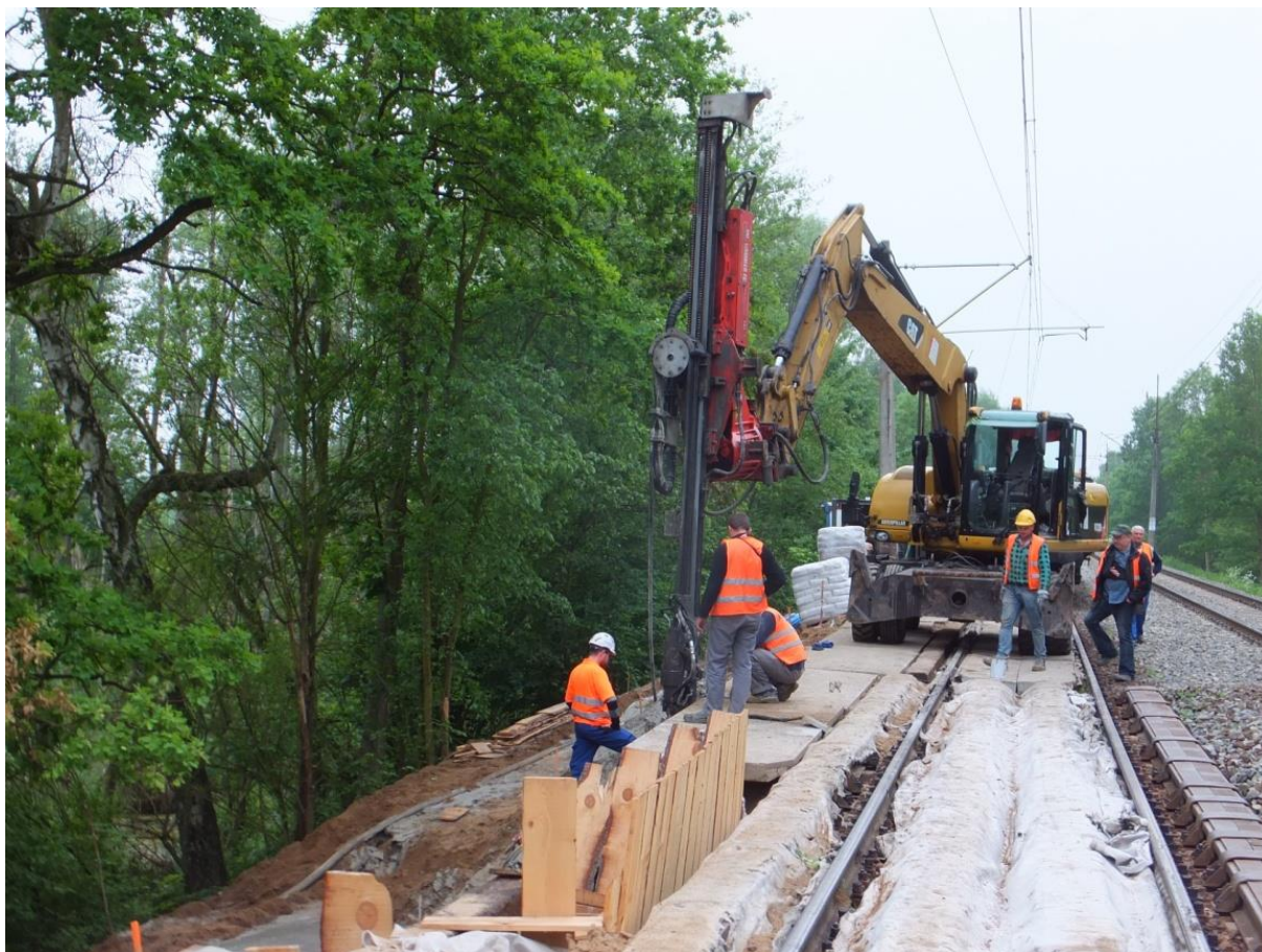
Fot. 14. Naprawcze roboty budowlane – wykonywanie iniekcji niskociśnieniowej
