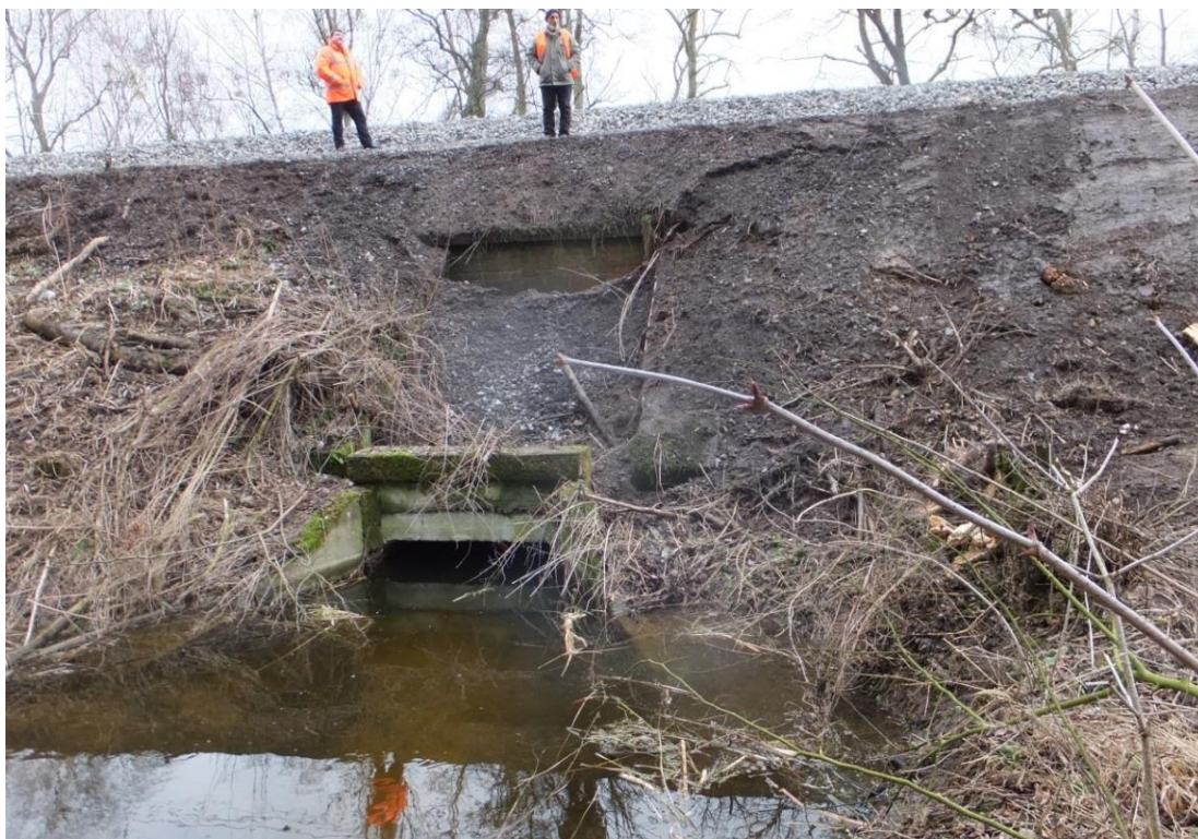
Fot. 12. Przepust ramowy żelbetowy prefabrykowany zainstalowany w przepuście sklepionym –cegłany z 1876r. Widok od strony toru nr 2
