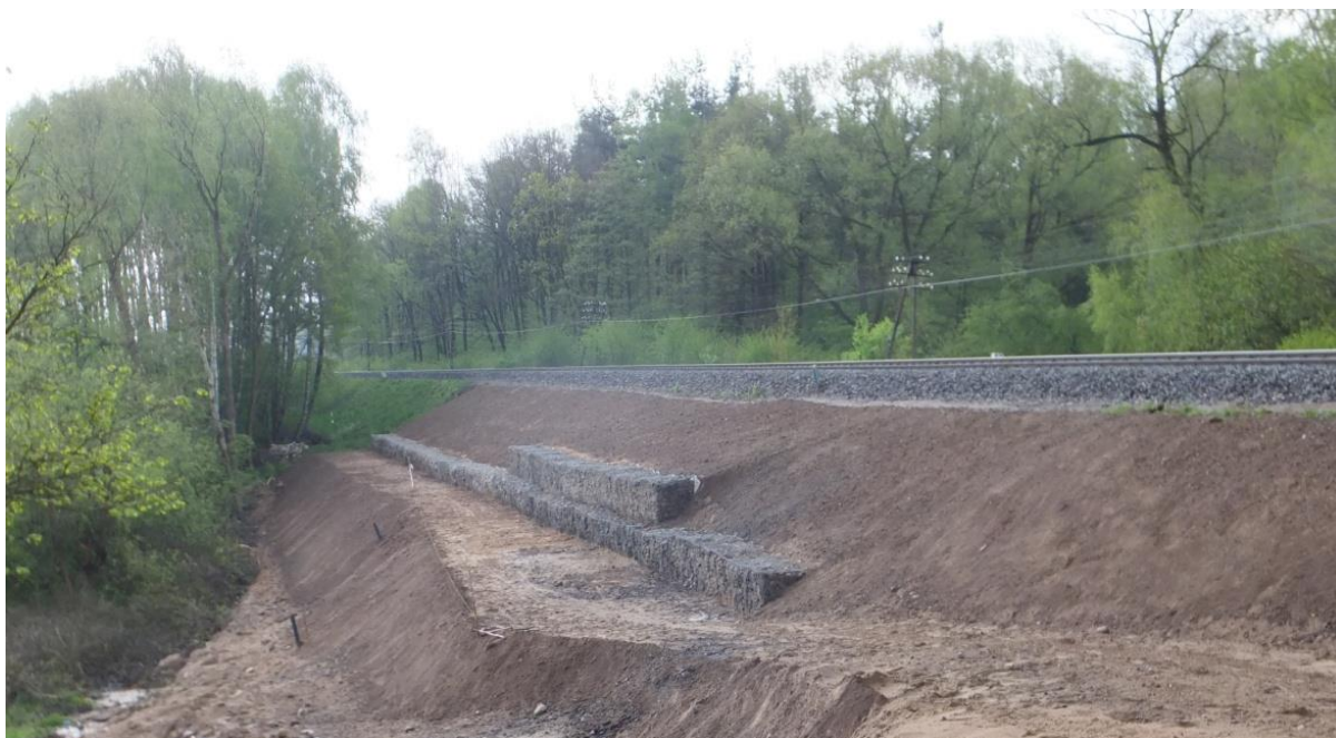
Fot. 17. Zakończone prace naprawcze
