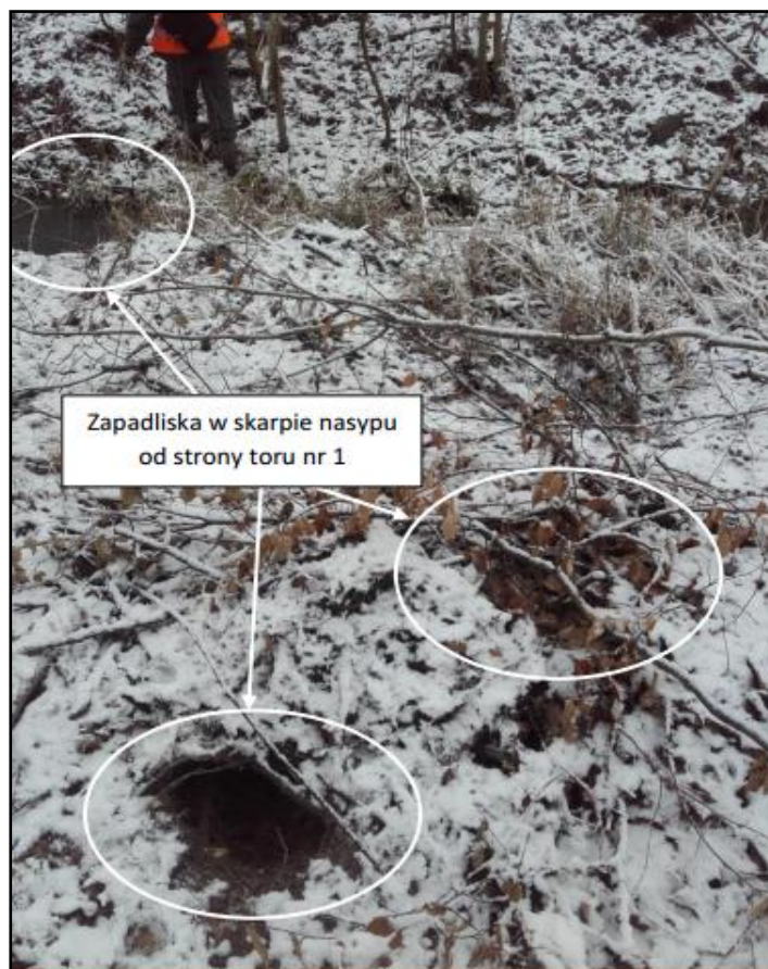
Fot. 24. Zapadliska w skarpie nasypu toru nr 1
