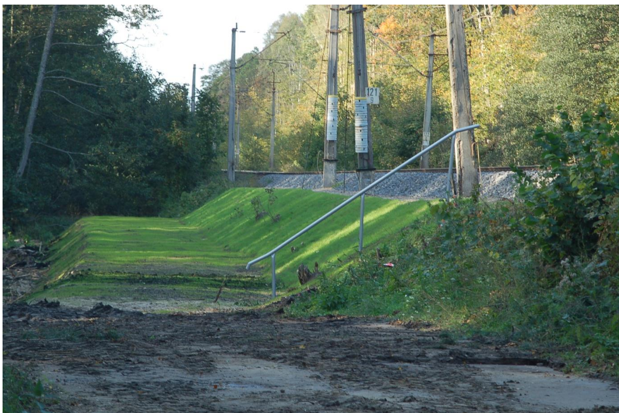
Fot. 26. Skarpa nasypu od strony toru nr 2 po wykonaniu naprawy
