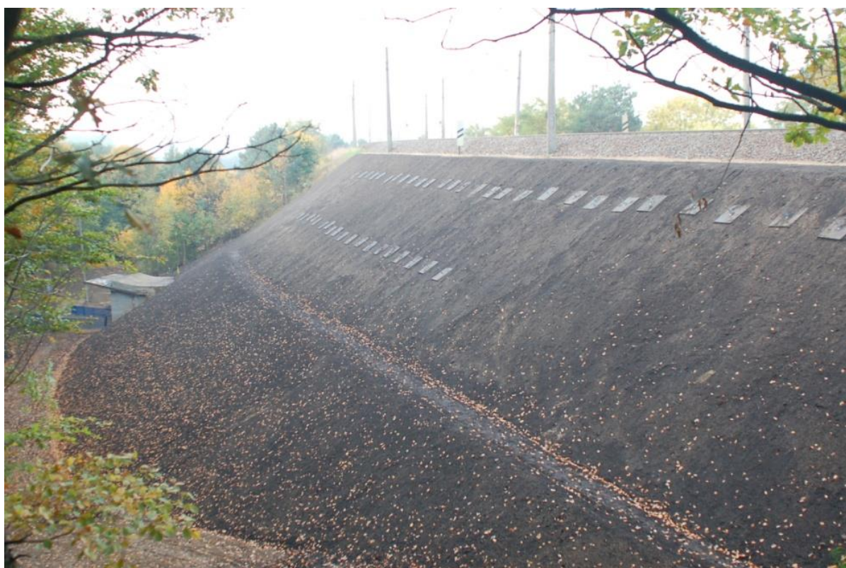
Fot. 3. Skarpa nasypu pod wykonaniu naprawy
