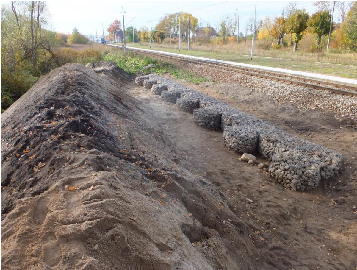
Fot. 8. W trakcie naprawy - nasyp konsolidujący oraz konstrukcja gabionowa
