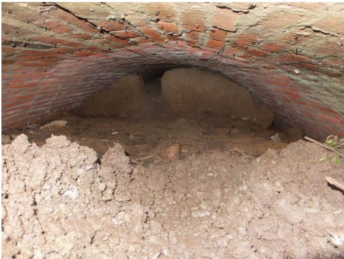
Fot. 13. Wewnętrzna część sklepienia przepustu ceglanego z 1876 roku
