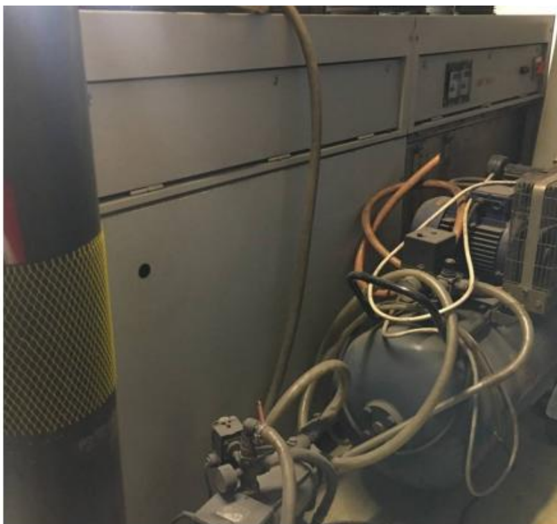
Rys. 10. Widok chłodnicy (w skład chłodnicy nie wchodzi kompresor oraz butla widoczne na zdjęciu)
