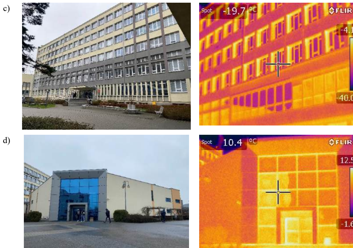
Fot. 4. Kompleks budynków dydaktycznych Politechniki Świętokrzyskiej (zdjęcia wraz z termogramami): a) A – Wydział Budownictwa i Architektury; b) B – Wydział Mechaniki i Budowy Maszyn; c) C – Wydział Zarządzania i Modelowania Komputerowego oraz d) Aula Główna
