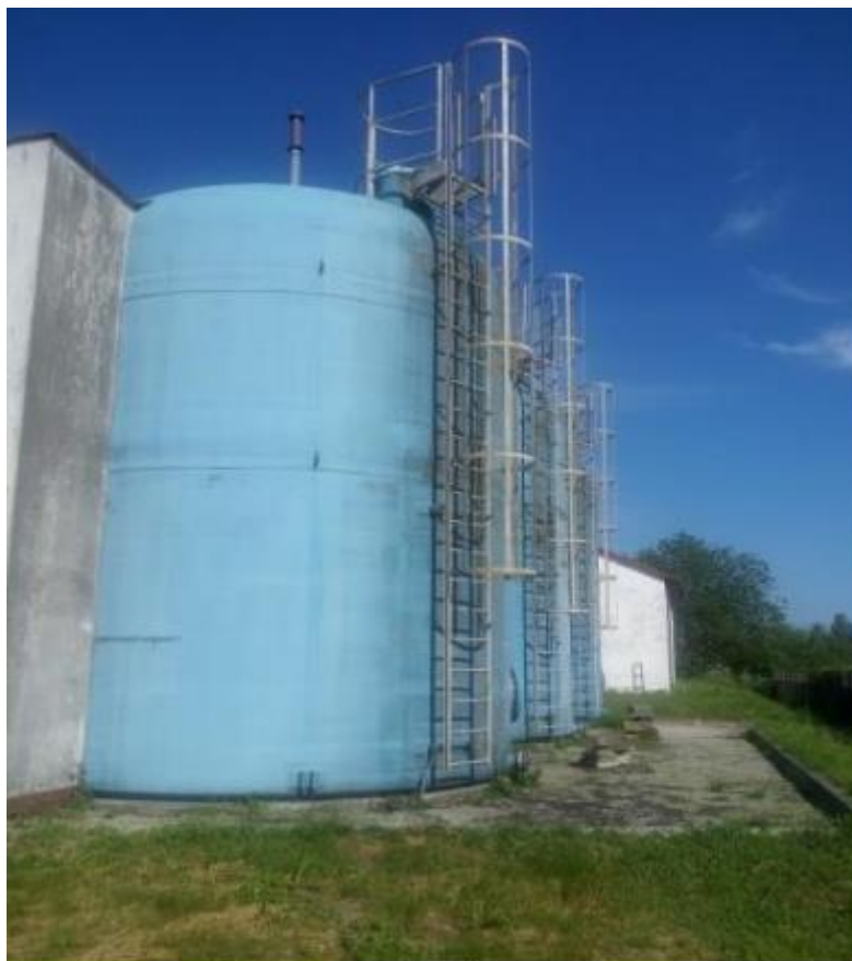
Rysunek 6.4 Reaktor SBR na oczyszczalni ścieków w Daleszycach (fotografia własna)
