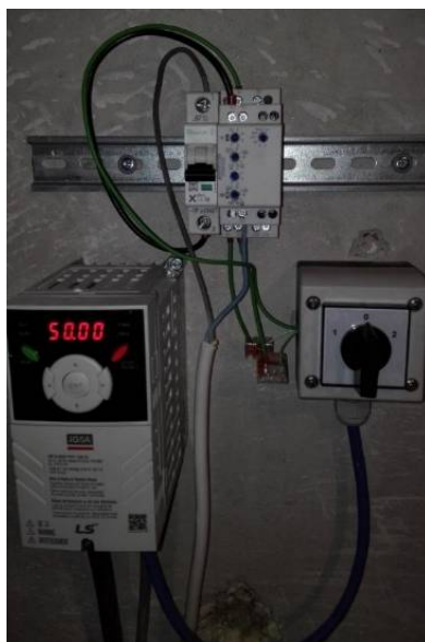
Rys. 33. Automatyka do sterowania wentylatorem.
