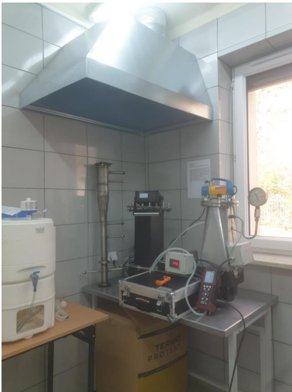
Ryc. 4.3. Autorska instalacja pirolizy i gazyfikacji z systemem wentylacji przeciwwybuchowej na Politechnice Świętokrzyskiej – widok ogólny
